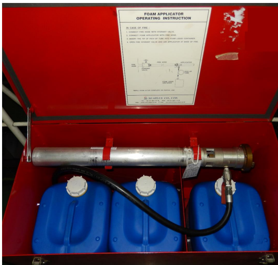
Slika 35: Oprema za pripravo gasilne pene
