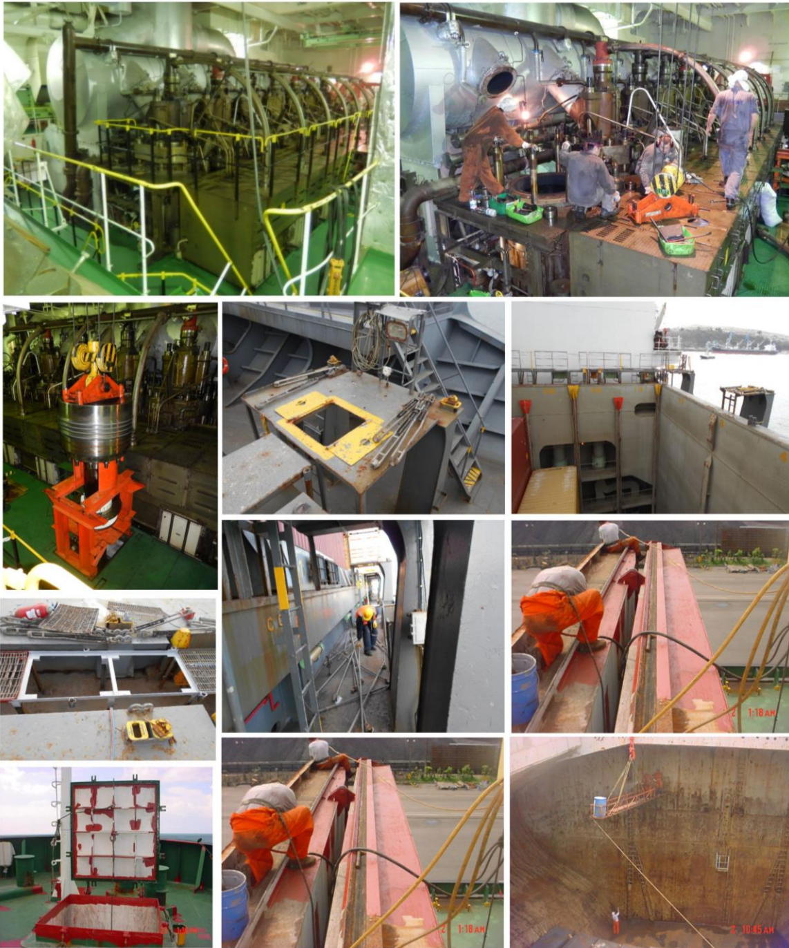
Slika 61: Nevarnosti padcev in poškodb na ladji
